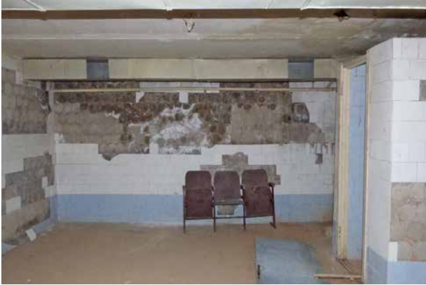
Подвал в здании бывшей линейной амбулатории станции Кондрашевская Новая
